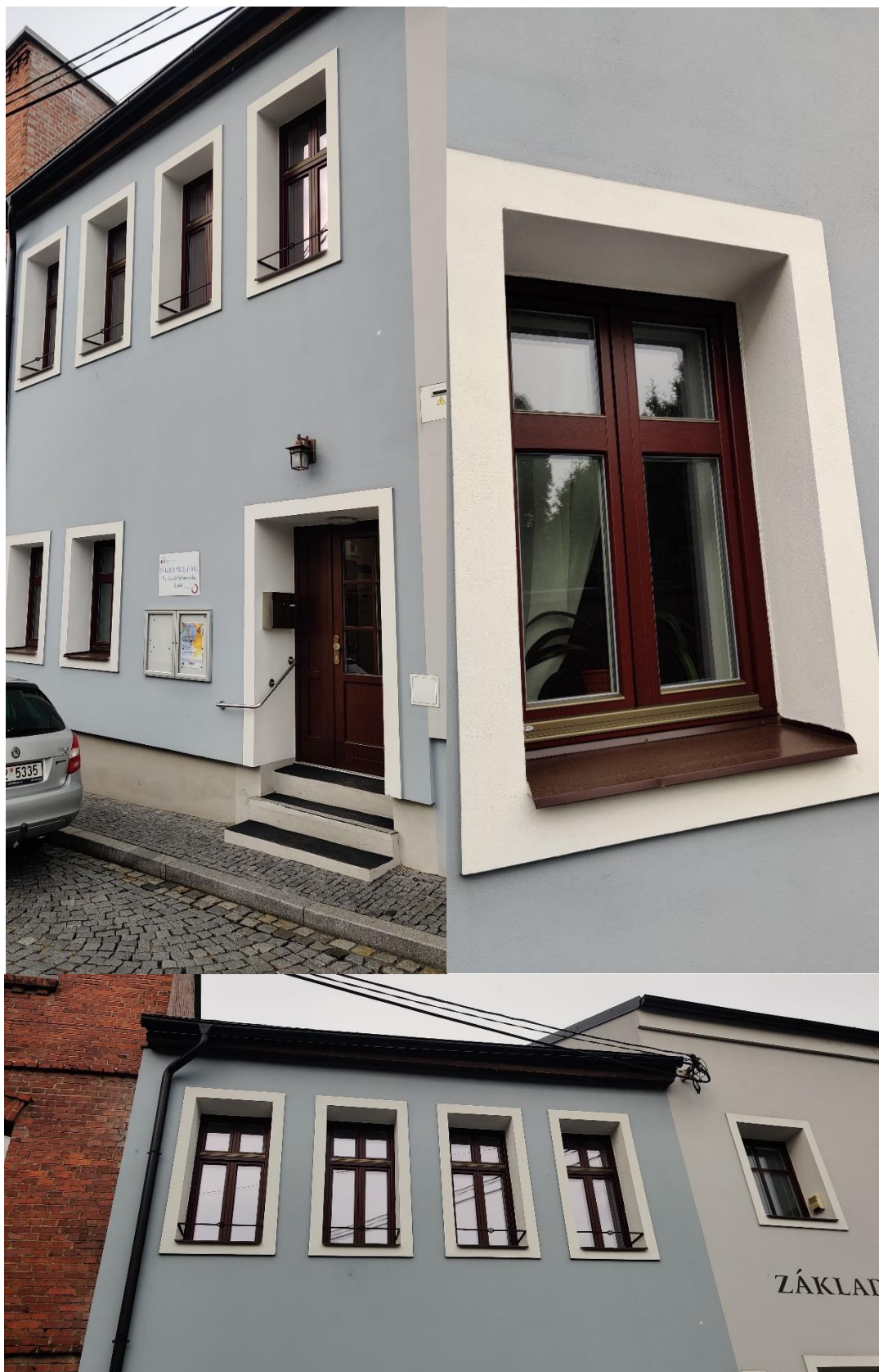
nová okna budovy U Bašty 613/4
